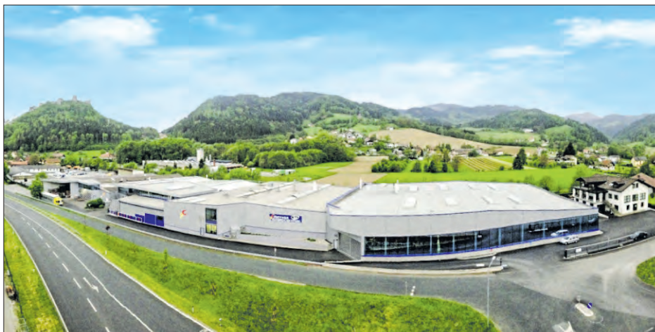
Der Hauptsitz der Griffner Metallveredelung in der Alten Hauptstraße 33, in Griffen. Demnächst eröffnet Werk 2 auf der gegenüberliegenden Straßenseite.
